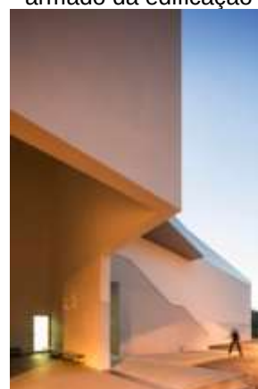
Figura 23 - Estrutura em concreto armado da edificação
