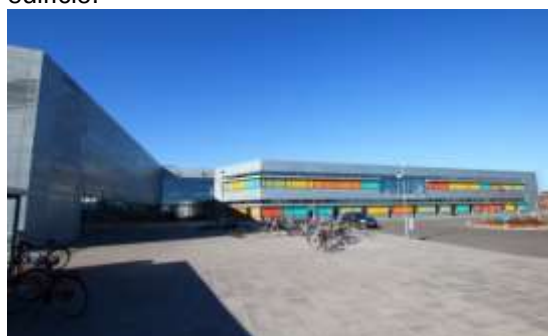
Figura 06 - Vista de uma das fachadas do edifício.
