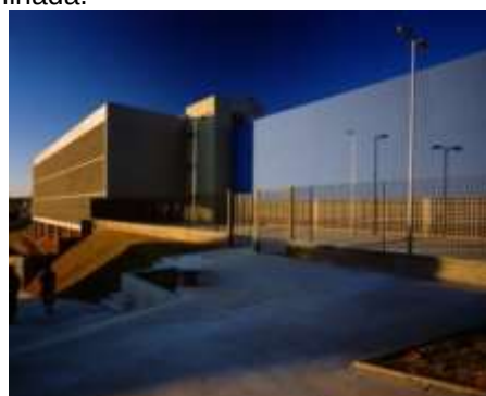
Figura 12 – Fachada pré-moldada frontal iluminada.
