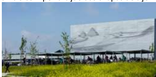
Figura 07 - Vista de uma das fachadas do edifício com perfuração das chapas de aço.
