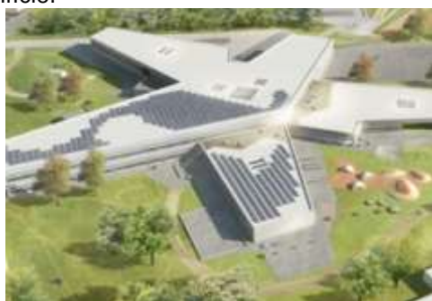
Figura 05 - Painéis solares instalados no edifício.
