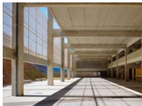
Figura 14 – Galpão com vistas para o pátio exterior
