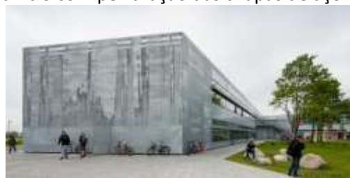
Figura 07 - Vista de uma das fachadas do edifício com perfuração das chapas de aço.
