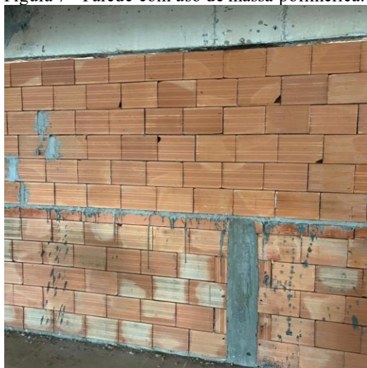
Figura 7 - Parede com uso de massa polimérica.
