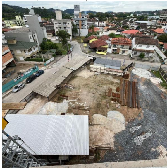
Figura 3 - Vista superior do canteiro.
