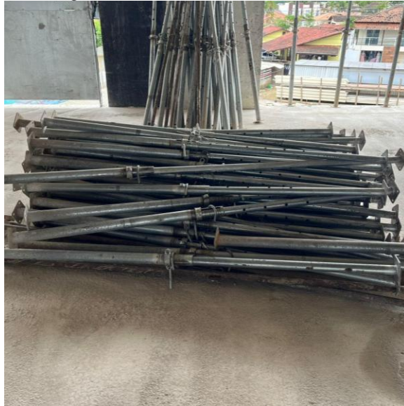
Figura 4 - Escoras metálicas.
