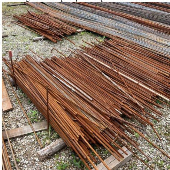
Figura 5 - Separação das pontas de barras.
