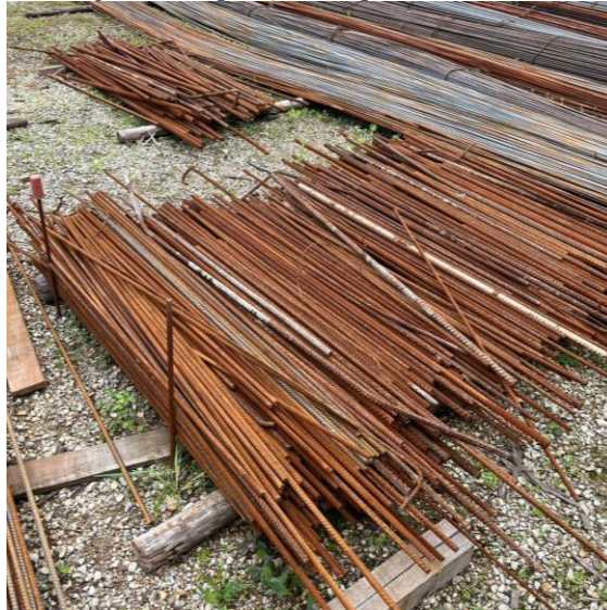
Figura 5 - Separação das pontas de barras.
