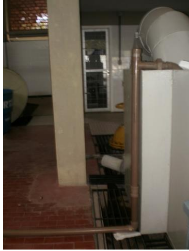
Figura 8 – Foto do sifão invertido utilizado para refinar o procedimento
